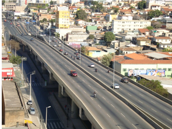
Figura 4-19 – Imagem do elevado monitorado (Av. Cristiano Machado)
