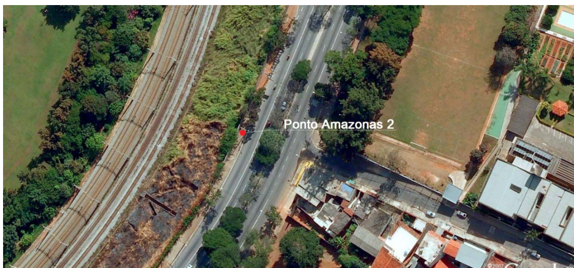
Figura 11 – Posicionamento do medidor de nível de pressão sonora: ponto Amazonas 2
