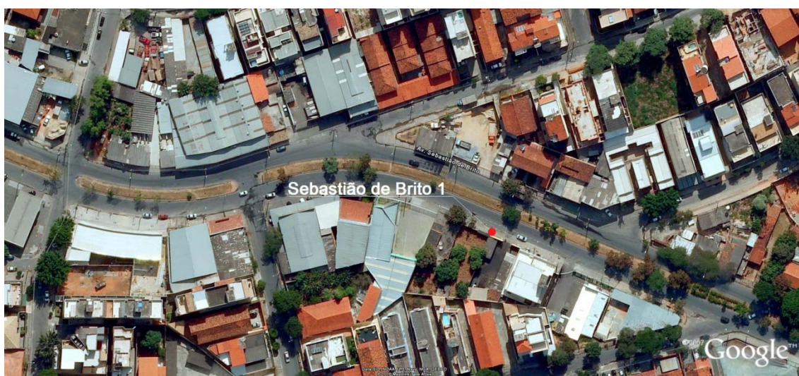
Figura 70 – Posicionamento do medidor de nível de pressão sonora: ponto Sebastião de Brito
